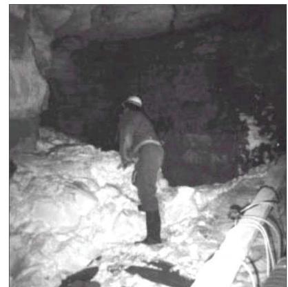
Injection sous pression d'une mousse dure de résine synthétique. Elle durcit rapidement, et comble les vides.
